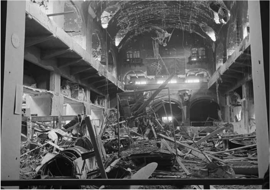
Abb. 3 Die zerstörte Mittelhalle des Sammlungsbaus des Deutschen Museums nach einem Bombenangriff am 21. Juli 1944.
