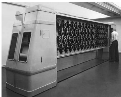
Abb. 7: Die zweite deutsche Gezeitenrechenmaschine (1935–1939).
