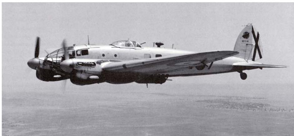
Abb. 5: Eine in Spanien gefertigte Casa C-2.111. Die beiden Rolls-Royce Merlin-Flugmotoren sind ein markantes Unterscheidungsmerkmal zu der Ursprungsausführung.
