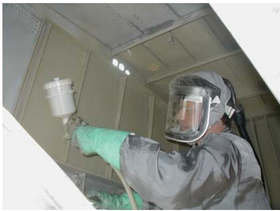
Die Innenräume des Flügelmittelteils und der beiden Außenflügel werden lackiert. Aufgebracht wurde eine Grundierung, die der vorgefundenen originalen Oberflächenbehandlung entspricht. Benötigt wurden 23 Liter Farbe, was einer Oberfläche von etwa 160 qm entspricht (Februar 2003).
