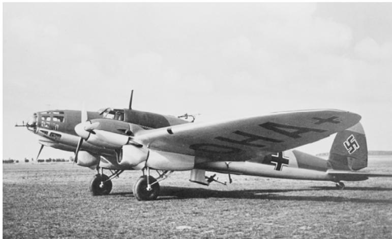
Abb. 2: Die ersten Ausführungen als Bomber für die deutsche Luftwaffe hatten noch einen abgesetzten Bug und einen elliptischen Flügelgrundriss.
