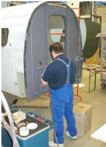
Nach dem Entlacken des Rumpfes beginnen die Reparaturarbeiten. Der im Bild sichtbare Spant bildet den hinteren Abschluss des Cockpits. Die Innenseiten sind bereits lackiert (Februar 2002).
