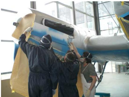
Lackierung des Rumpfes. Die Trennlinie der Farben wird, hier bei der rechten Motorverkleidung, mit Hilfe einer Schablone gespritzt, damit ein weicher Übergang entsteht (Mai 2009).
