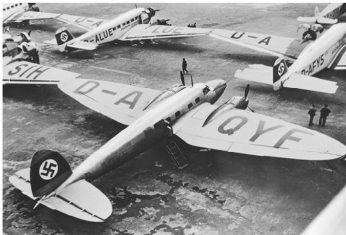
Abb. 1: Heinkel baute für die Lufthansa zwölf Heinkel He 111 in der Ausführung als Verkehrsflugzeug.
