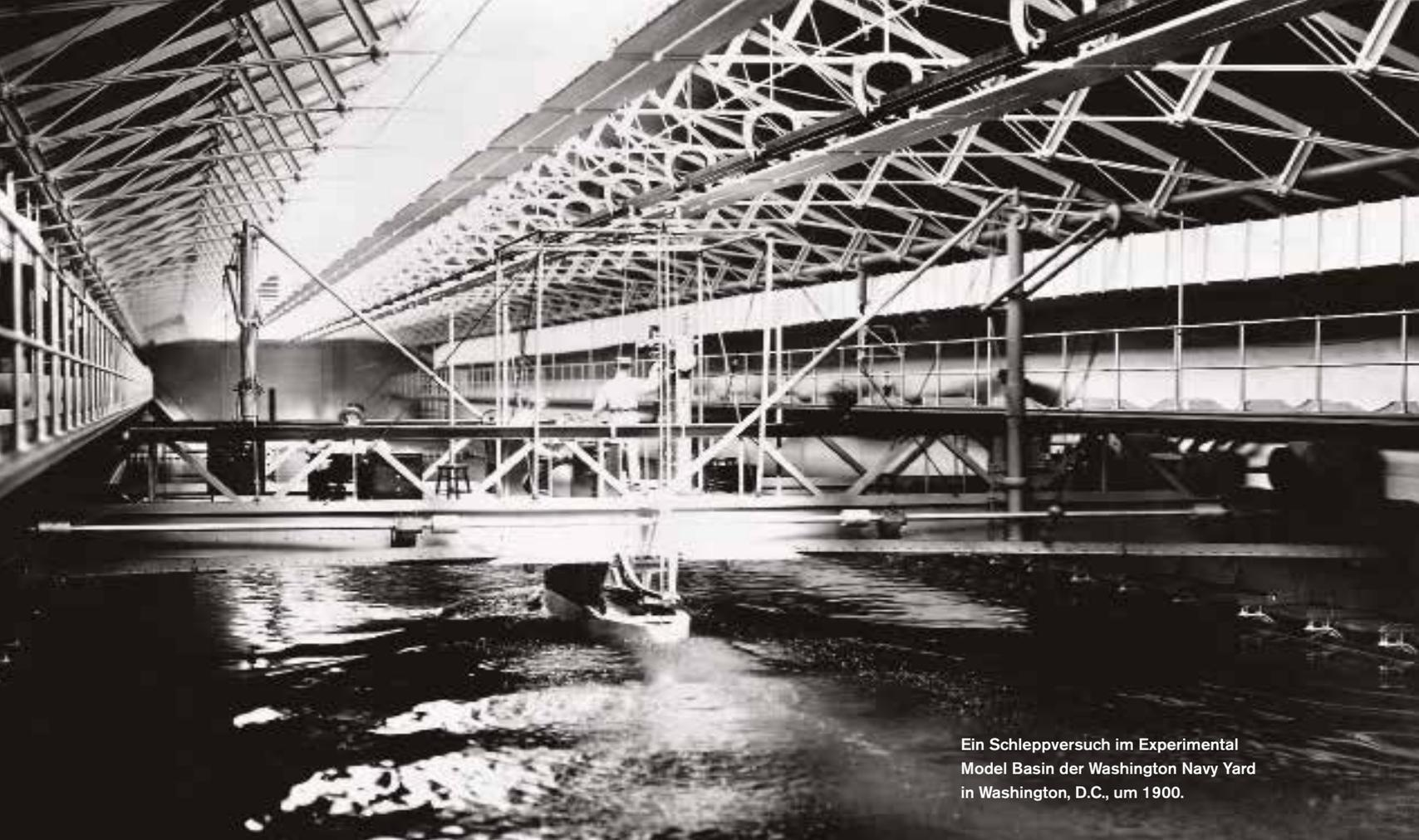
Ein Schleppversuch im Experimental Model Basin der Washington Navy Yard in Washington, D.C., um 1900.
