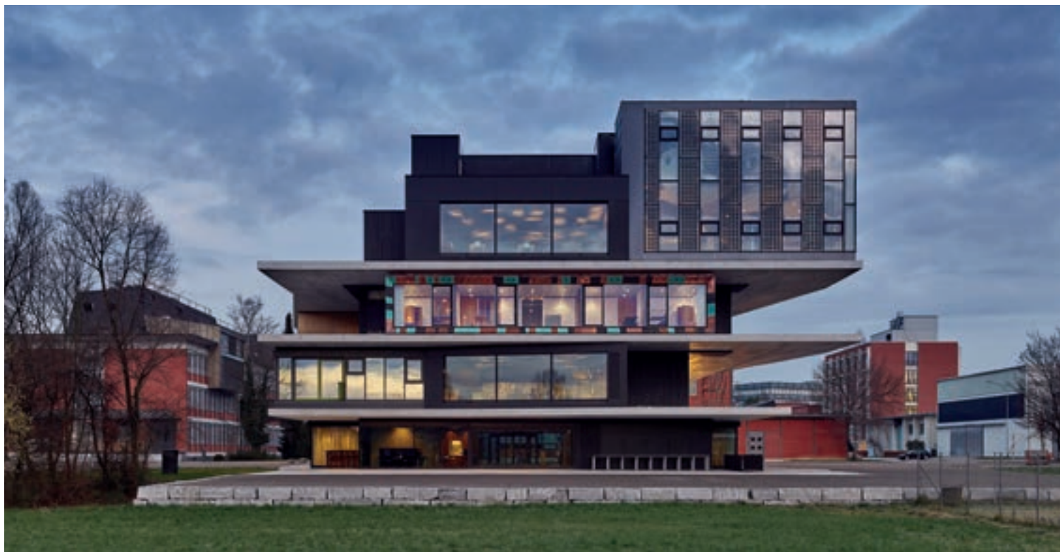
Ein Gebäude, das komplett aus wiederverwendbaren oder wiederverwertetem Material gebaut ist, steht vor der Eidgenössischen Materialprüfungs- und Forschungsanstalt bei Zürich. Es dient als Prototyp für die Möglichkeiten nachhaltigen Bauens.
