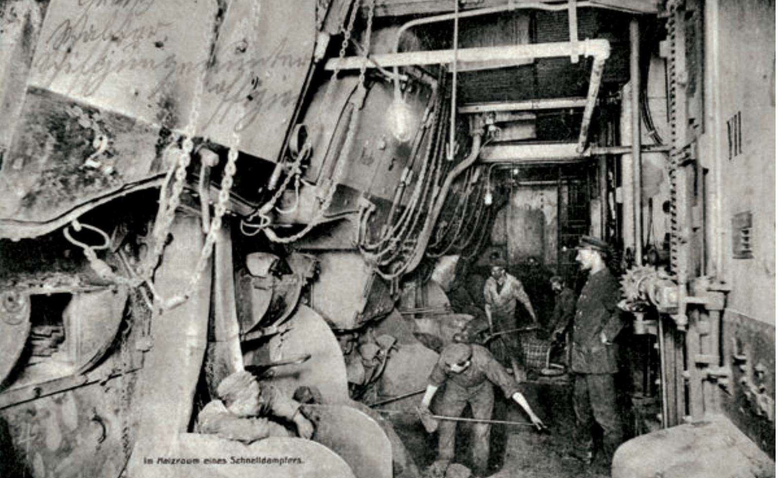
Blick in den Heizraum eines Schnelldampfers.
