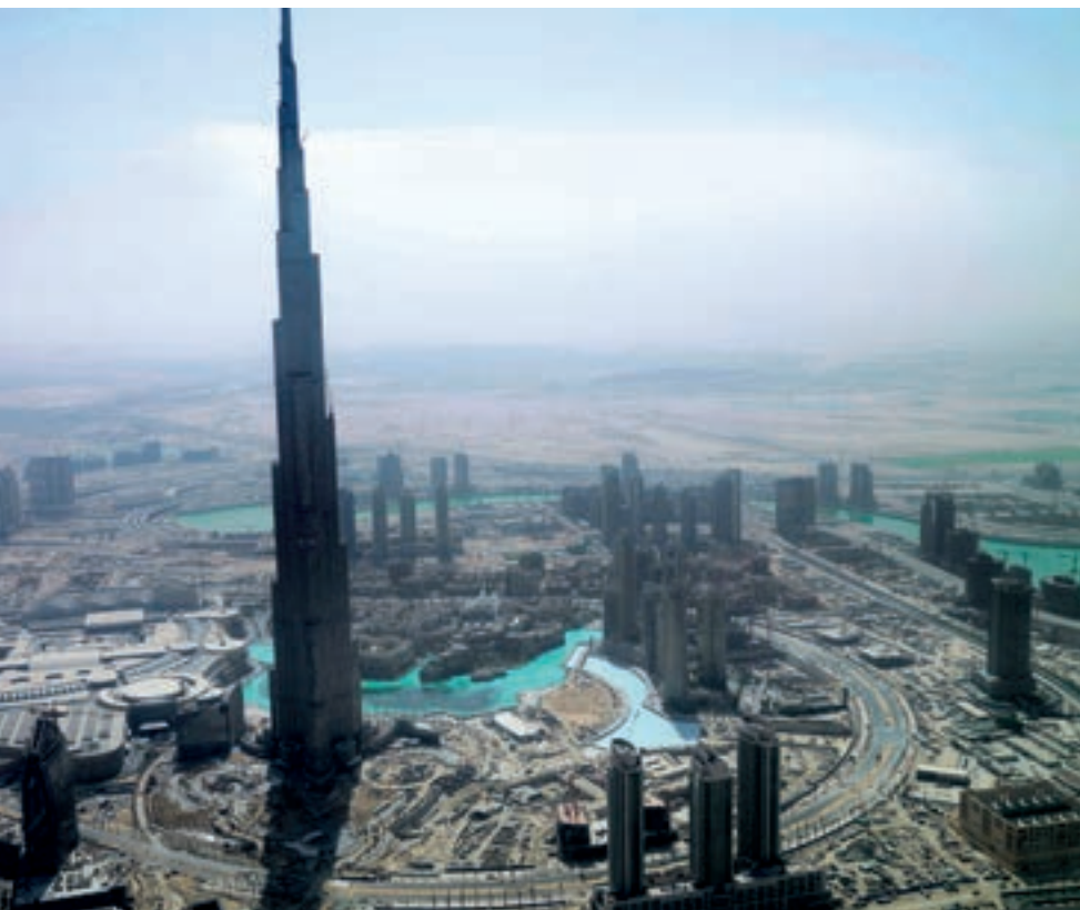
828 Meter misst das höchste Gebäude der Welt, der Burj Khalifa in Dubai. Für den Wolkenkratzer mit 160 Stockwerken wurden mehr als 330 000 Kubikmeter Beton verbaut.
