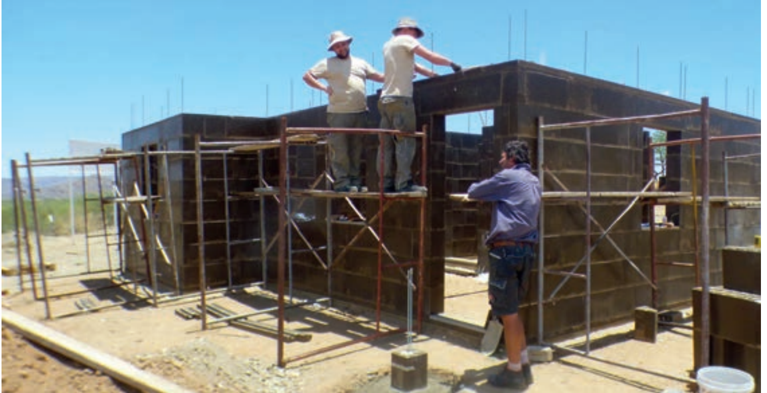
Ein Thüringer Unternehmer hat ein System entwickelt, um vorgeformte, günstige Bausteine aus Sand oder Schutt zu gießen. Als Bindemittel dient Polyesterharz. Das abgebildete Haus entsteht in Namibia.
