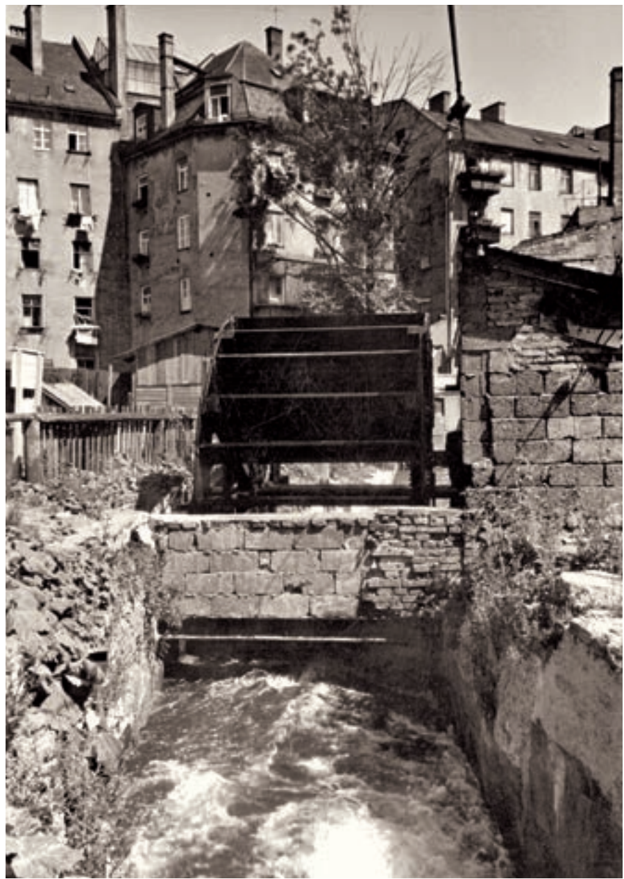
Der durch Bombenschäden offen liegende Katzenbach am Reichenbachplatz. Foto von ca. 1952.
