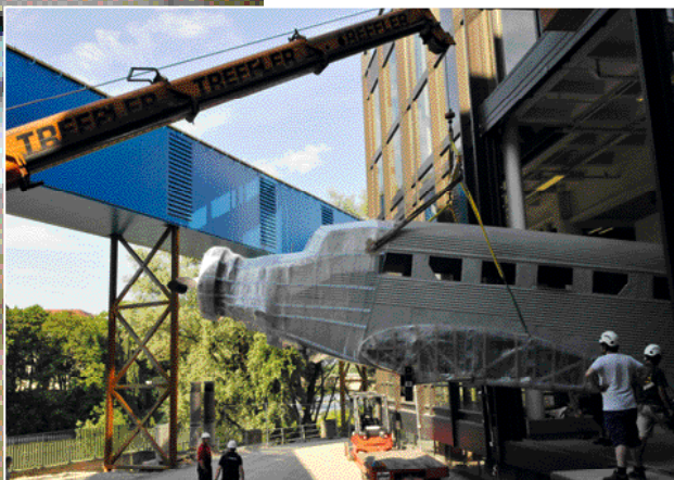
Bild oben: Mit einem Kran wird die alte Ju aus der Luftfahrrhalle gehoben. Erst 2019 wird sie zurückkehren.
