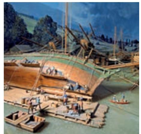
Ein Schiff wurde mit Flaschenzügen geneigt (kielgeholt), um das Unterschiff mit dünnen Kupferplatten beschlagen zu können. (Abteilung Schifffahrt)
