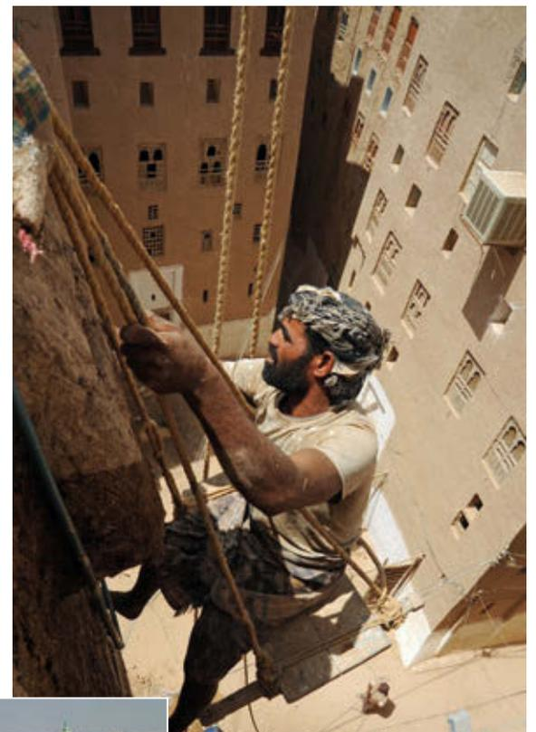
Aus Lehm wurden die Hochhäuser der Stadt Shibam im Jemen gebaut. Der Bauarbeiter muss schwindelfrei sein: Für Reparaturen an der Fassade sitzt er auf einem Brett, das vom Dach herabgelassen wird.
