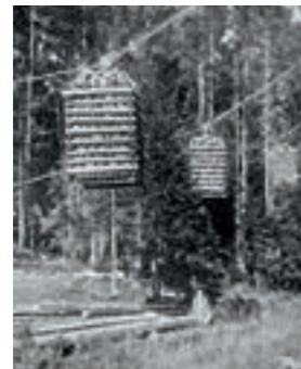
Bild rechts: Spanngewichte für die Bergantenne ermöglichen ein Nachgeben der Antennenseile bei Belastung.
