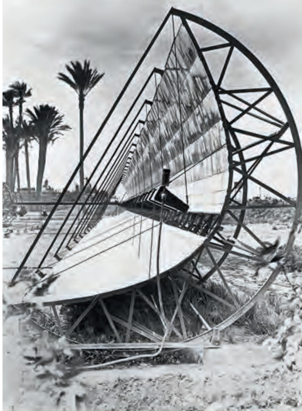
Blick in eine der fünf Parabolrinnen, in deren Brennpunkt sich ein Verdampfer befindet.
