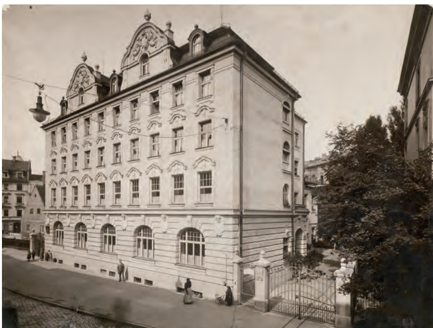
Neubau des Königlich Bayerischen Arbeiter-Museums in der Pfarrstraße 3, München (Außenansicht), 1907.
