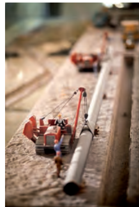
Rohrlegeraunen, die im Abstand von 25 Metern positioniert sind, heben den Leitungsstrang in den Graben.
