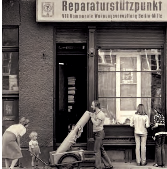
Reparaturstützpunkt der kommunalen Wohnungsverwaltung in der DDR, 1981.
