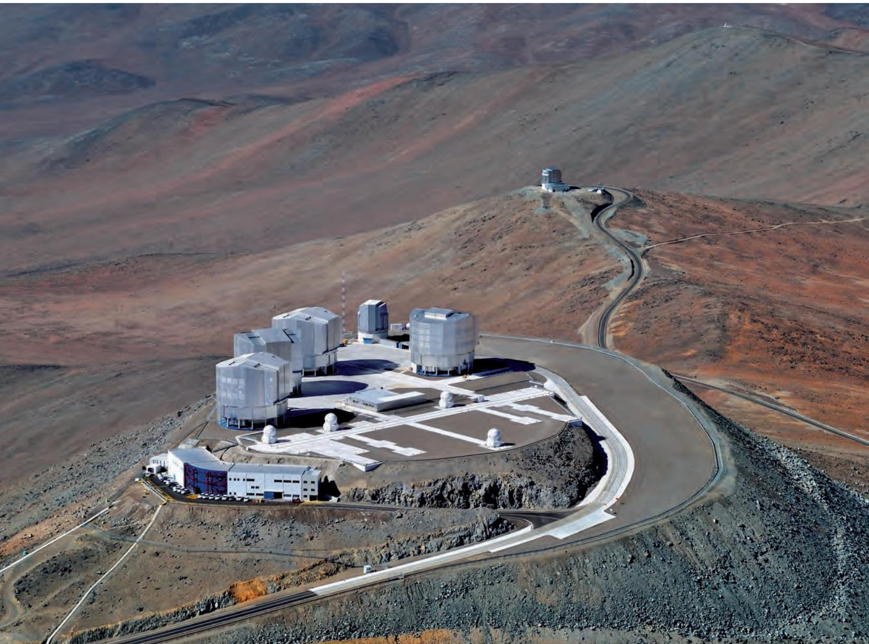
Ab 1987 baute die ESO das Very Large Telescope auf den Cerro Paranal in der chilenischen Atacama-Wüste. Es gehört zu den größten Teleskopen der Welt. Für seinen Bau wurde sogar der Gipfel des Paranal gesprengt und eingeebnet.
