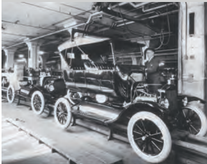
Der weltweite Siegeszug des Automobils wurde auch durch Erfindungen und Verbesserungen bei der Produktion gefördert. Die Bilder zeigen Fließbandanlagen der Ford-Werke Highland Park. Oben die Fahrwerkmontage, unten die Montage der Karosserie.
