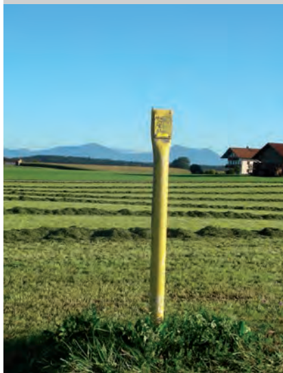
Pipelines werden nicht nur oberirdisch (Abb. links), sondern über weite Strecken unterirdisch geführt. Gelbe Markierungen – wie diese am Heimatort des Autors im Chiemgau – zeigen, wo die Rohre verlaufen.
