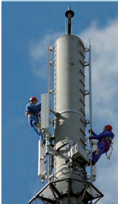
Techniker bei Wartungsarbeiten an einem Funkmast.
