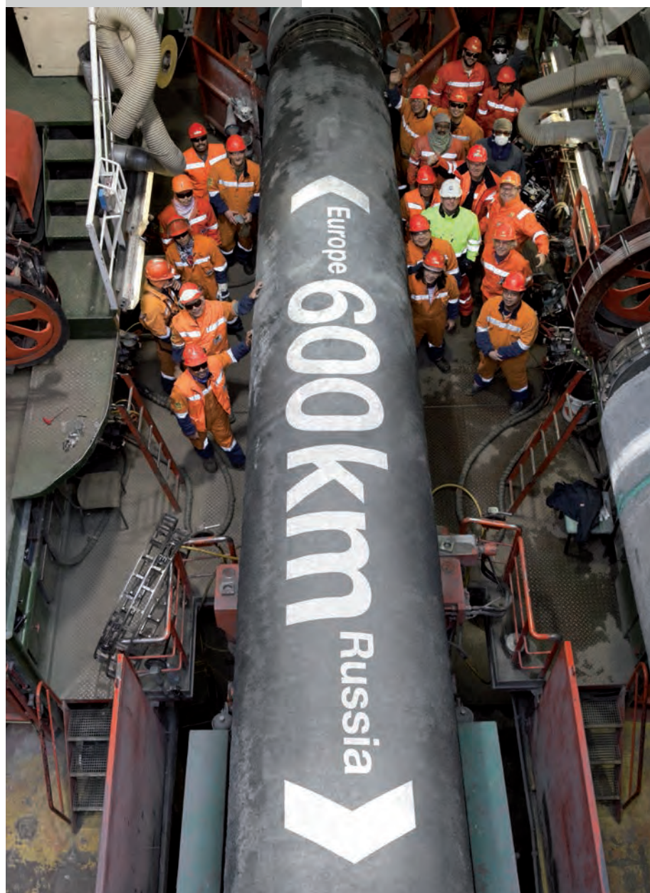
Die Hälfte des ersten Strangs der Nord-Stream-Pipeline wurde im November 2010 fertiggestellt. Für diesen Anlass hat die Besatzung des Verlegeschiffs Castoro Sei ein Rohrsegment mit einer speziellen Markierung versehen.
