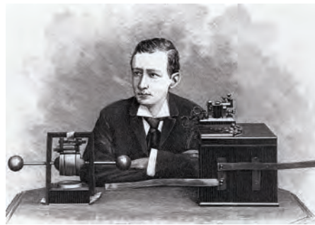
Guglielmo Marconi posiert auf diesem Holzschnitt vor Teilen seiner Versuchsanordnung zur drahtlosen Telegrafie aus dem Jahr 1895. Links ist der Dipol als Sendeantenne, rechts auf dem Kasten eine Morsetaste zu sehen.
