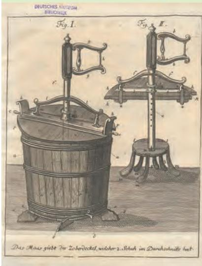
**Die eigens für seine Versuche erdachte Konstruktion baute Schäffer zur ersten, handbetriebenen Haushaltswaschmaschine um.**
