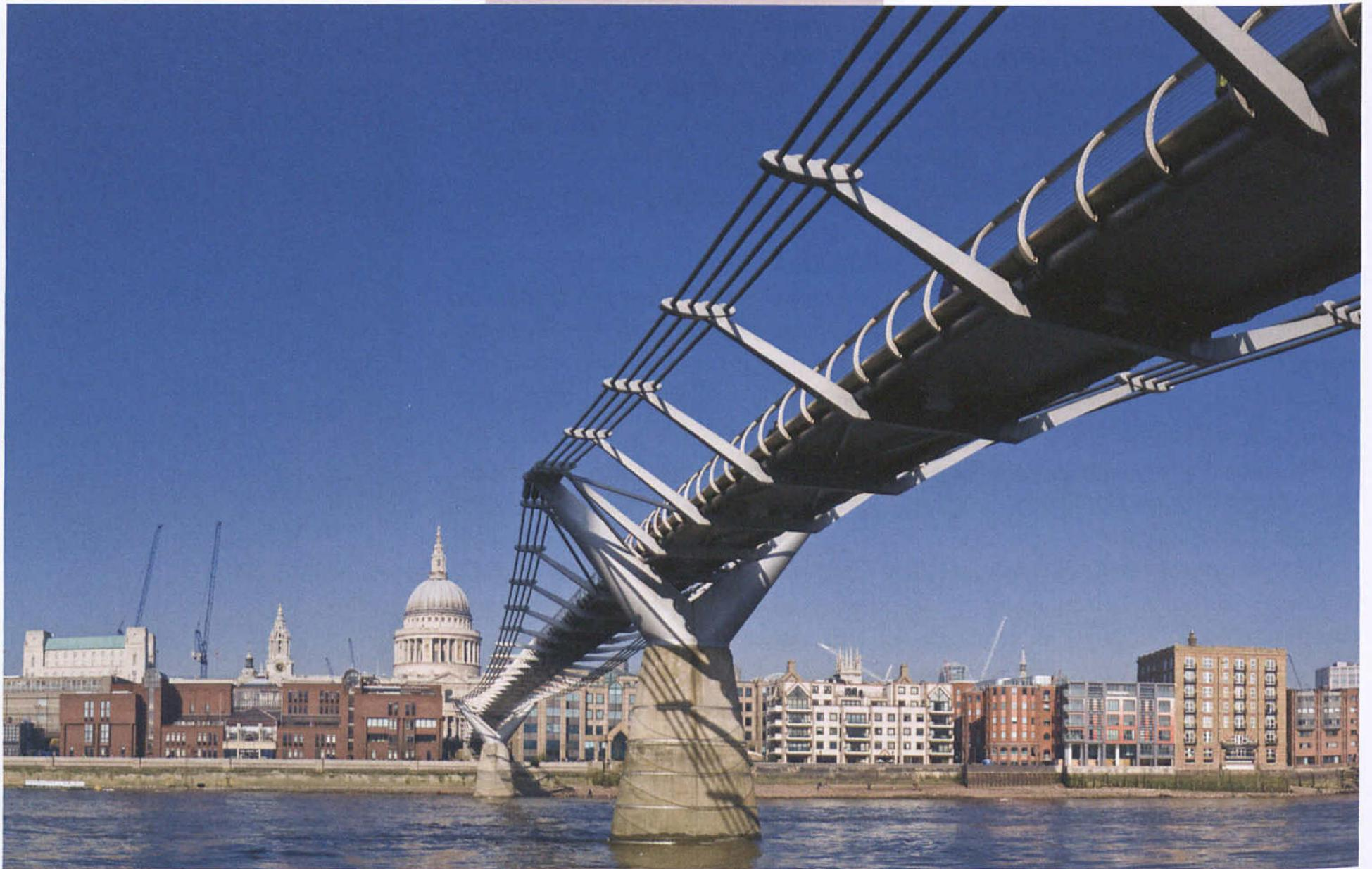
**Bild 7:** Die Millenniumsbrücke in London/England. Die spektakuläre Hängebrücke wirkt grazil und elegant, benötigt allerdings aufgrund der großen Seilkräfte massive Fundamentkörper.
