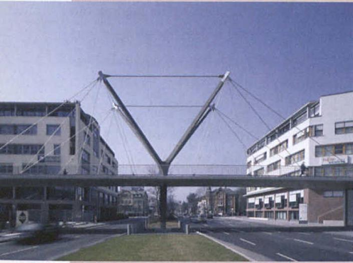
Bild 3: Fußgängerbrücke in Bad Homburg. Maste aus Grantblöcken tragen den Betonüberbau.
