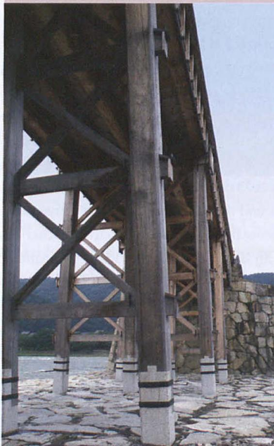
Erst wenn der Wasserspiegel sinkt, erkennt man, dass die Streben aus Holz auf Schuhen aus Werkstein stehen, damit die Balkenköpfe wieder trocknen können und nicht so schnell verfaulen.
