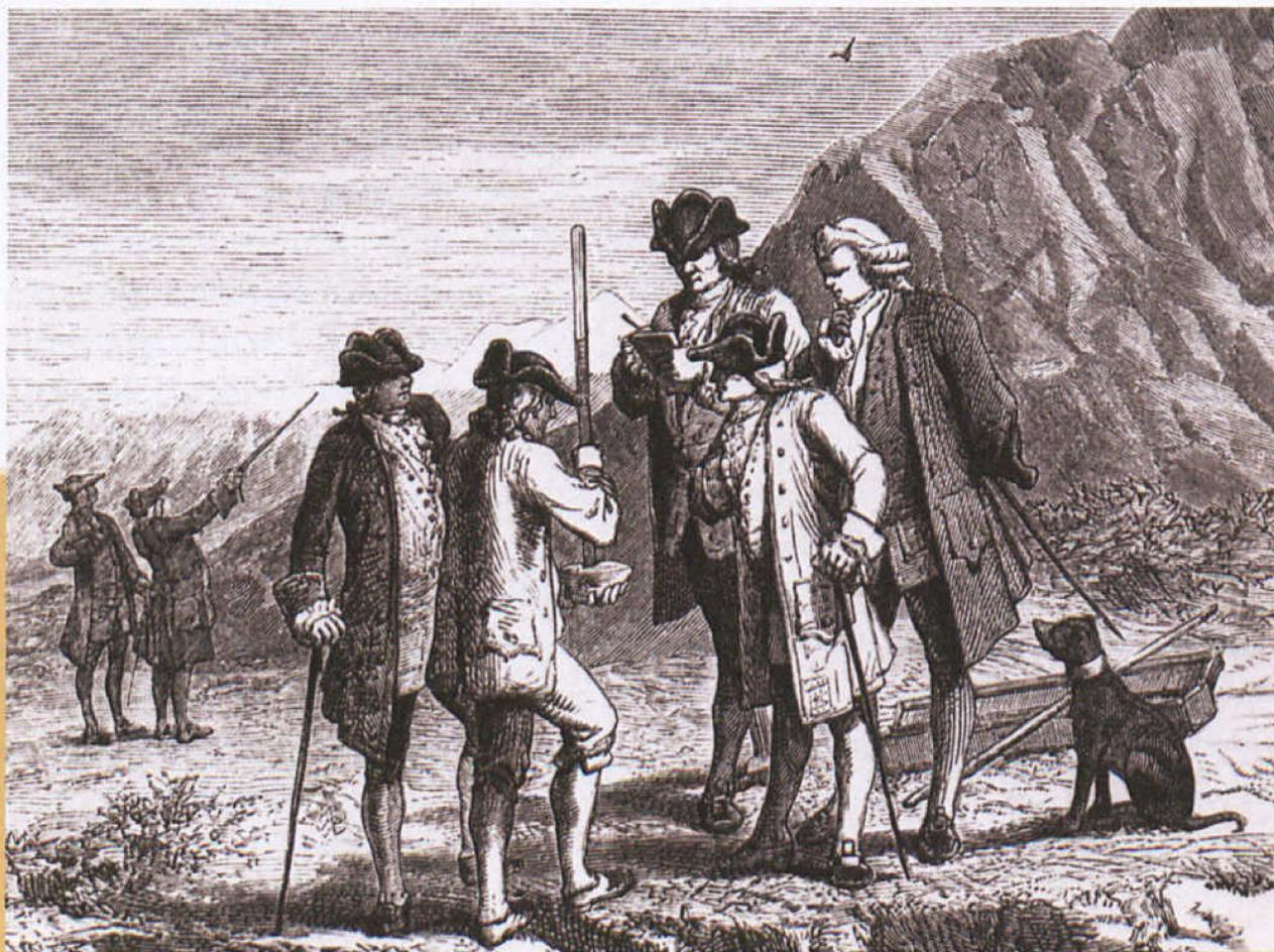
Blaise Pascal stellte fest: Auf einem Berg ist der Luftdruck geringer. Deshalb steigt das Quecksilber in der Glasröhre nicht so weit nach oben. Das Bild zeigt Pascals Schwager beim Messen des Luftdrucks, 1648. (Stahlstich, ca. 1870)
