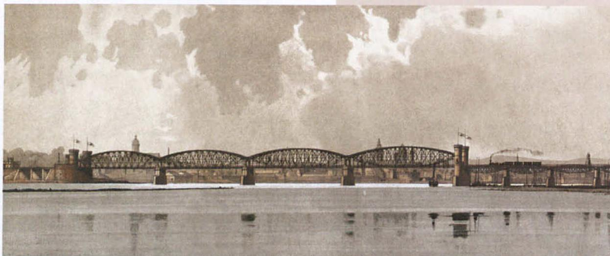
ein mit Gelenken versehener Auslegerträger, eine praktikable Lösung. Außerdem verwendete er beim Bau der Simbacher Innbrücke 1870 erstmals in Süddeutschland die Caissonbauweise für Fundamente.
