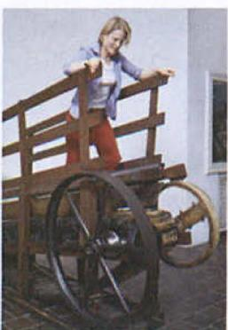
Die tierische bzw. menschliche Antriebskraft wird bereits seit der Antike genutzt. Dieses Tretwerk wurde von Alfred Pieper aus Moers um 1900 zum Antrieb landwirtschaftlicher Maschi-
