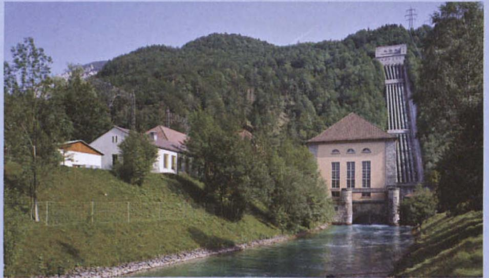
Durch sechs Rohre stürzt das Wasser vom hoch gelegenen Walchensee in die Tiefe, und treibt so die Turbinen des Kraftwerks an.
