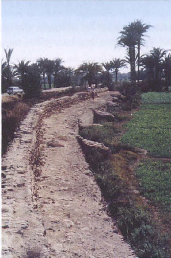
Eine Ersatzmauer nach einem 116 m breiten Wasserdurchbruch südlich von Shidmuh. Rechteckiger Mauerquerschnitt mit luftseitigen Strebepfeilern und Aufsatzmauer.
