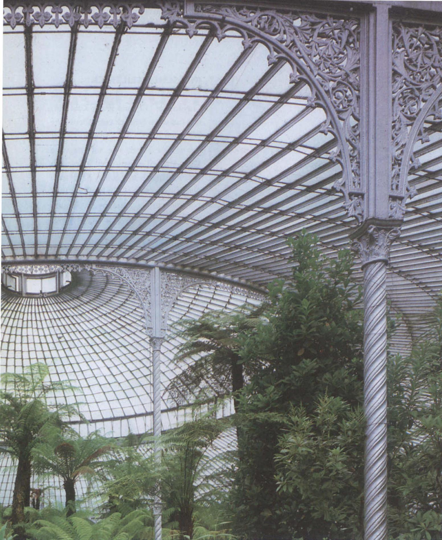
1872 ließ John Kibble in Glasgow den gläsernen Pflanzenpalast nach eigenen Entwürfen bauen. Bemerkenswert ist die extreme Reduzierung der tragenden Konstruktion.
