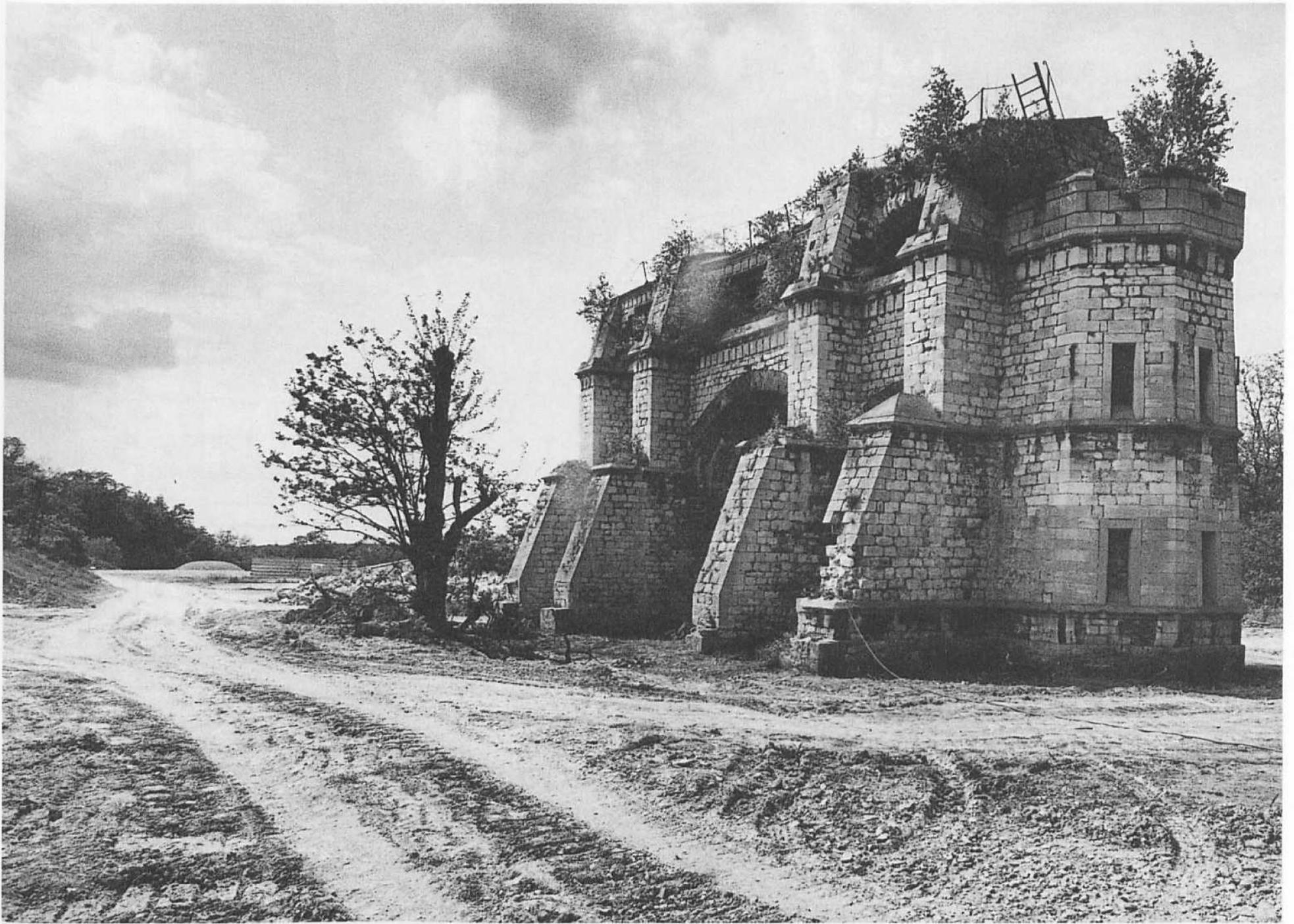
Ein Seilscheibenpfeiler, erbaut 1871, mit dessen Hilfe die Verbindung zwischen Bruchsohle und Bruchkante hergestellt wurde.
