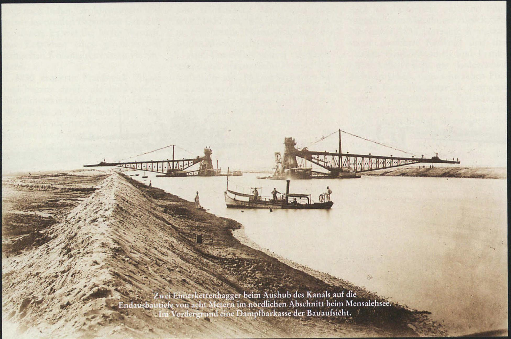
Zwei Eimerkettenbagger beim Aushub des Kanals auf die Endausbautiefe von acht Metern im nördlichen Abschnitt beim Mensalehsee. Im Vordergrund eine Dampfbarkasse der Bauaufsicht.
