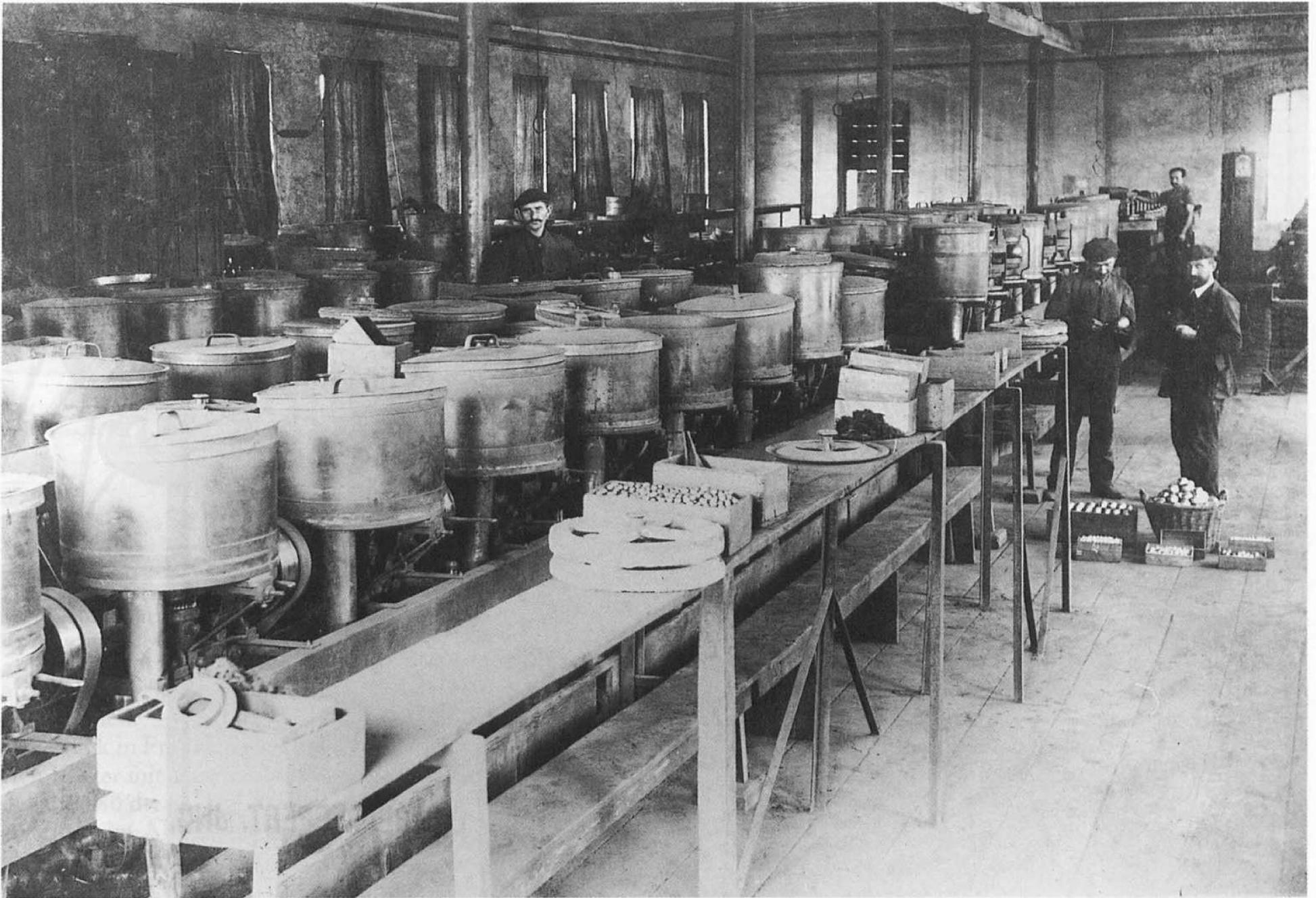
Kugelschleifmaschinen bei Friedrich Fischer – vermutlich rechts im Bild –, der ein neues Verfahren zur Kugelherstellung einführte.
