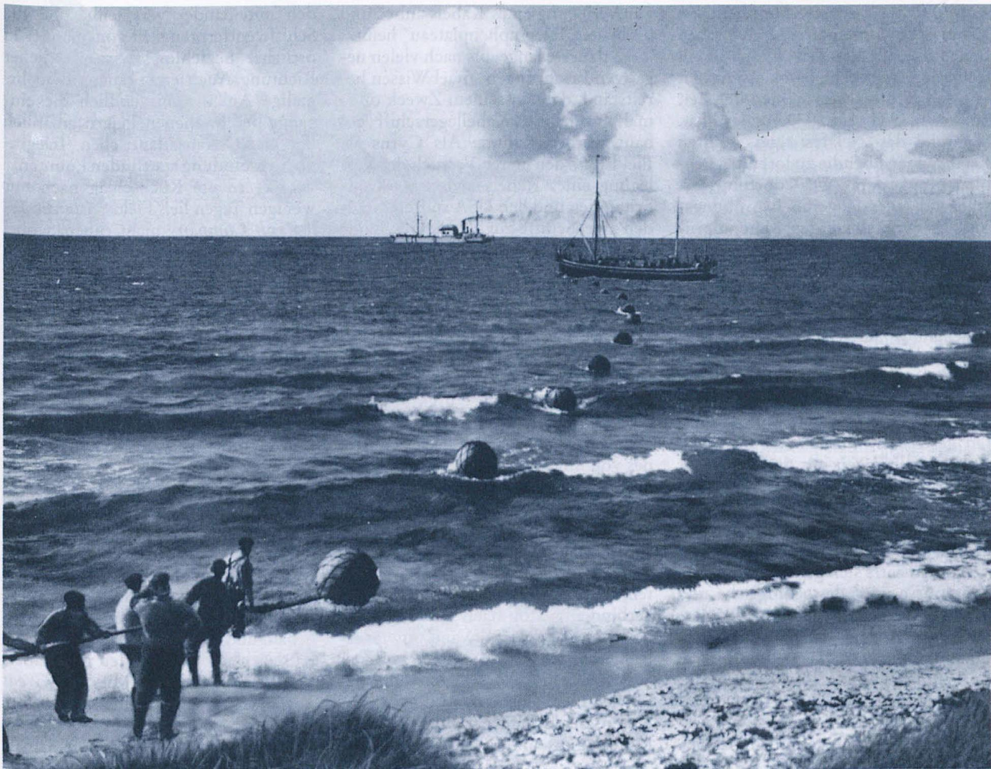
Anlandung eines Seekabels mit Hilfe von Schwimmkörpern, um 1910. Um diese Zeit war die Kabelverlegung zur Routine geworden.
