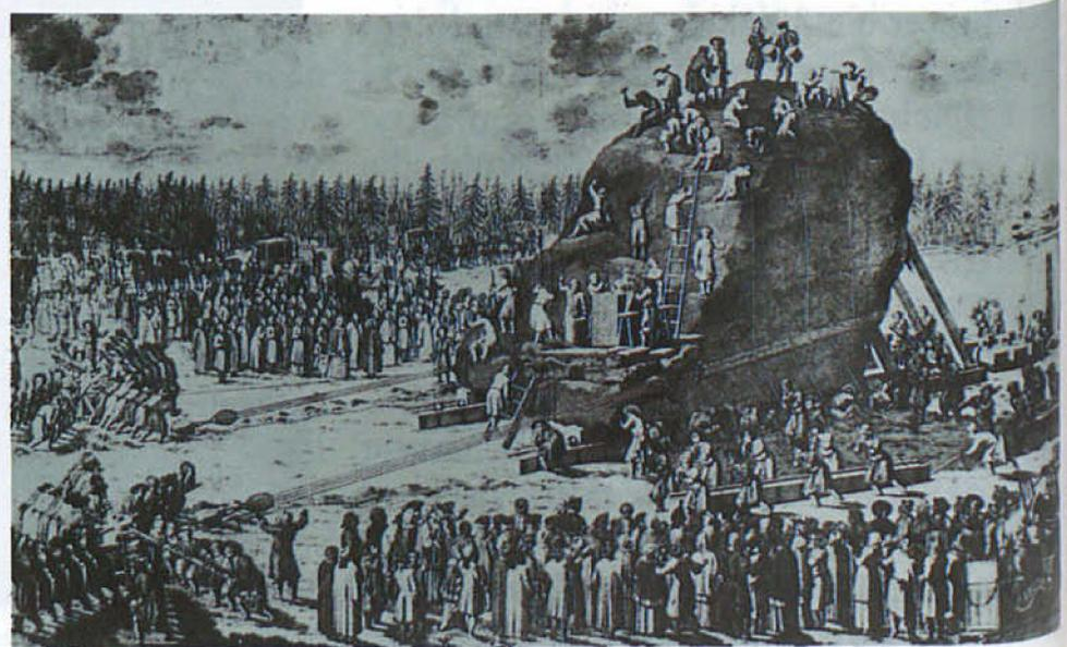
und zur Drehung des Kolosses erstmals **Kugellager** in Anwendung kamen. Die technische Leitung des aus Finnland transportierten Riesensteins hatte der griechische Abenteurer Graf **Marin de Carhuri**.
