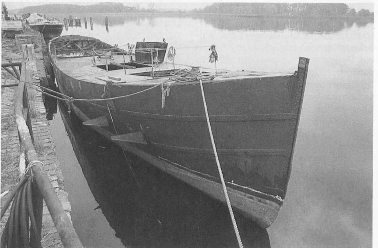
Der nach Wolgast geschleppte Rumpf eines englischen Fischkutters, aus dem die „Puritan“ mit einer Segelfläche von maximal 1000 Quadratmetern wiederentstehen soll.
