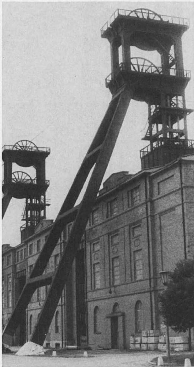
*Kaliwerk Buggingen mit den Schachtanlagen Baden und Markgräfler; einst größter Industriebetrieb des südlichen Rheintals, 1973 stillgelegt. Bemerkenswert sind die vollwandigen Profile der Stützen sowie Streben der Gerüste (Foto Deutsches Bergbaumuseum Bochum, 1974)*
