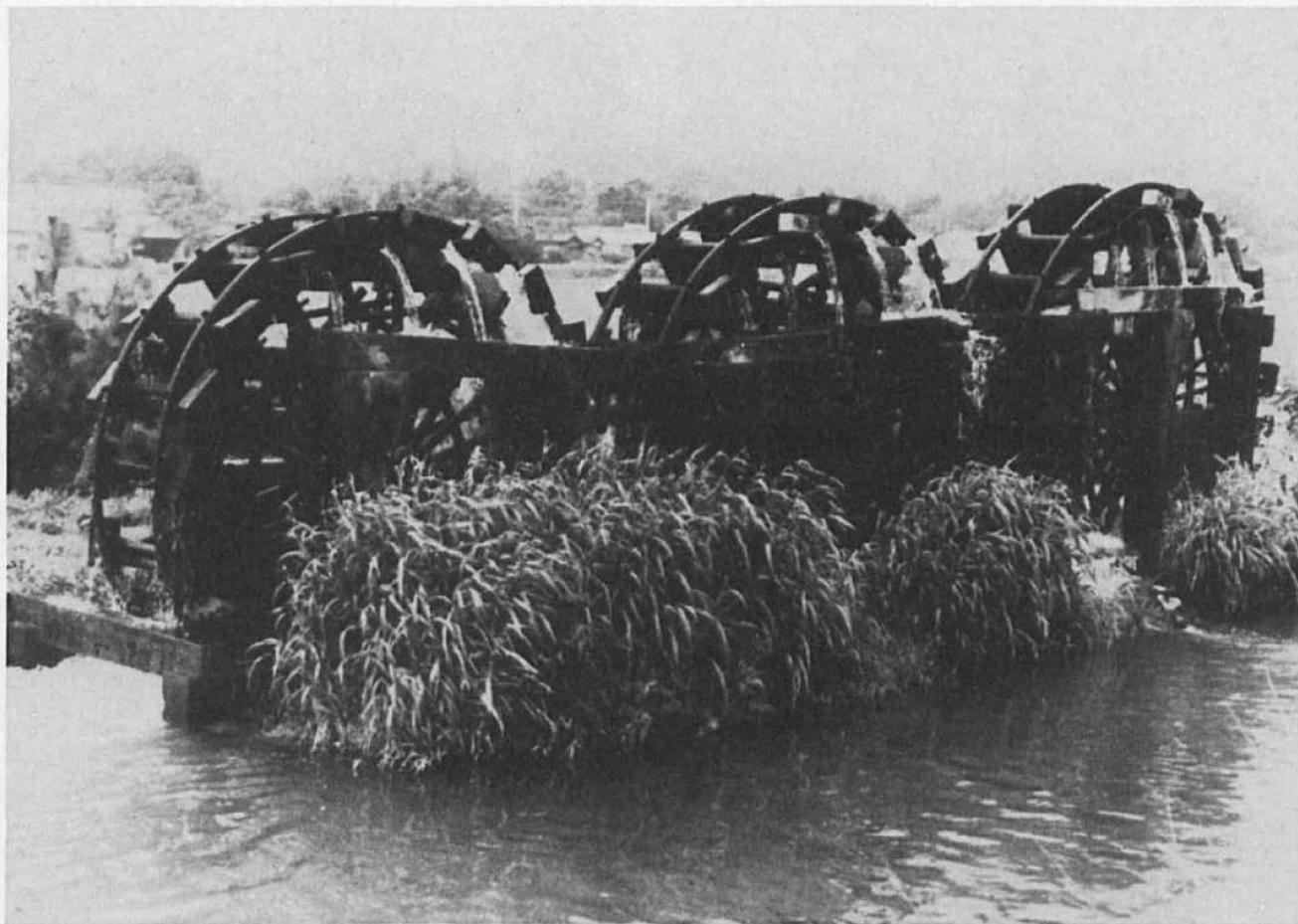
*Wasserradkombination in Asakura, Präfektur Fukuoka. Ein seltenes Beispiel hohen technischen Könnens. Die durch den Flußlauf angetriebenen Räder befördern in kleinen, seitlich am Rad angebrachten Trögen Wasser in eine Rinne, die das Wasser in die Felder leitet. Bauzeit: Anfang 19. Jahrhundert (seither mehrmals renoviert); Bewässerungsfläche 13 ha; Betriebszeit: Mai bis Oktober.*
