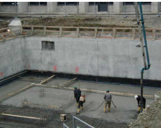
Im Dezember 2013 wurde die wasserdichte Bodenplatte betoniert – mit ca. 70 t Stahl und 60 cm stark.
