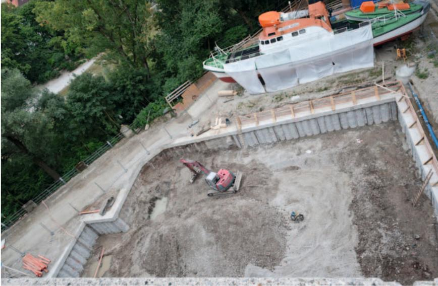
Nach Fertigstellung der Bohrpfähle wird im August 2013 die Baugrube für die neue Elektrozentrale im Museumsgarten ausgehoben.
