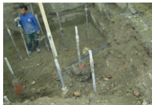
Mikropfahlgründung der neuen Treppen: Arbeiten unter dem Kellerniveau des historischen Sammlungsbaus.
