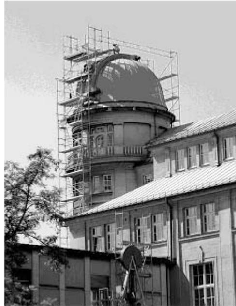
Einige Schadstellen am Kupferbelag der Sternwartenkuppeln hatten in den vergangenen Jahren zu Undichtigkeiten geführt. Durch die erforderlichen Reparaturarbeiten war der Betrieb beider Sternwarten in den Sommermonaten stark eingeschränkt.
