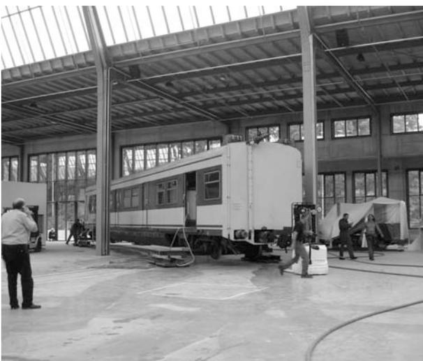
Zentimetergenaue Arbeit war in Halle I gefordert, um die Münchner S-Bahn mit Luftkissen zwischen den Säulen durchzuschieben.
