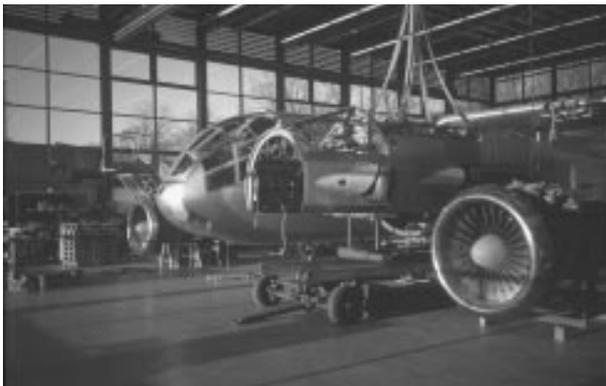
Triebwerksmontage am Senkrechtstarter Do 31
