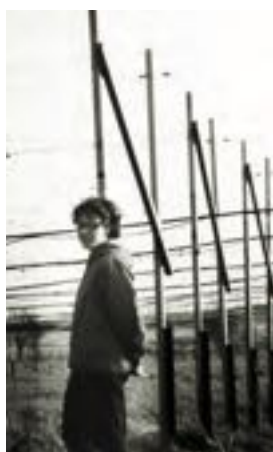
Die Radioastronomin Jocelyn Bell vor dem Array aus zusammengeschalteten Dipolantennen, mit dem sie 1967 zum ersten Mal Signale von einem Pulsar detektieren konnte.
